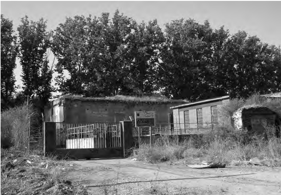
Elevadora del Canal de Isabel II dentro del Cuartel de las Guardias Españolas.
